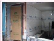
施工中屋内の進捗確認
